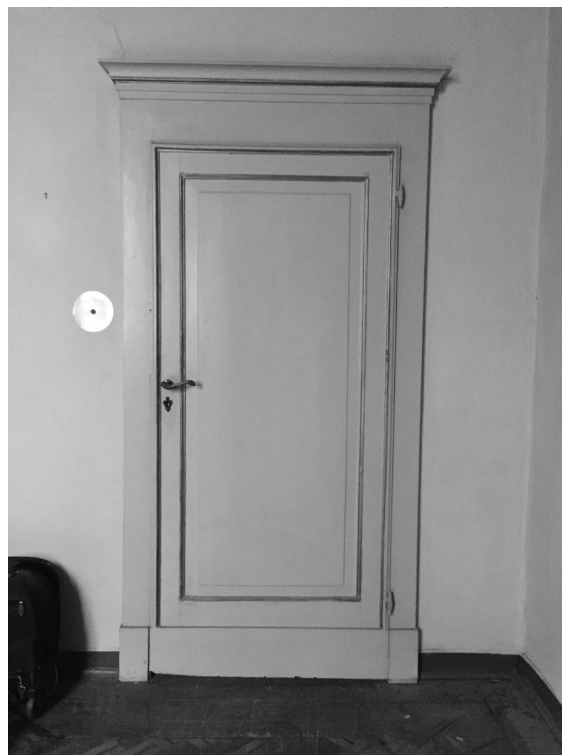
Foto 13-14– Infissi interni da recuperare o da realizzare nuove con prestazione acustica su disegno.
