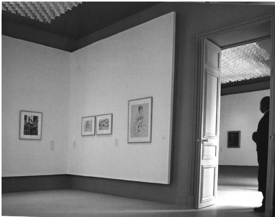
Foto 11 – Esempio di Pannelli fonoassorbenti per correzione acustica degli ambienti
