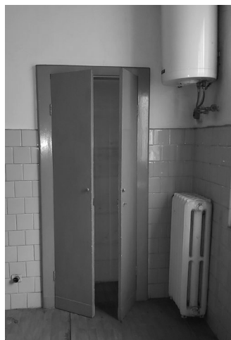
Foto 1-2 – Nicchie su muratura portante che verranno chiuse con tecnica cuciscuci.
