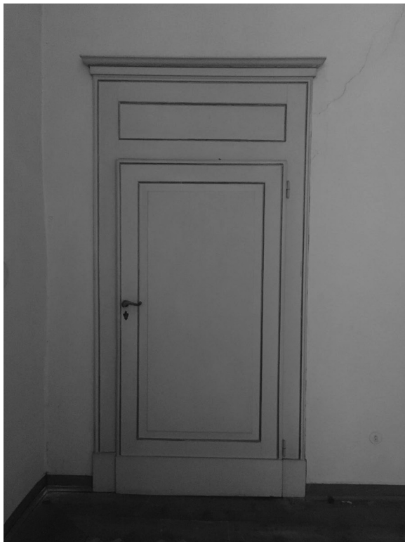
Foto 13-14– Infissi interni da recuperare o da realizzare nuove con prestazione acustica su disegno.
