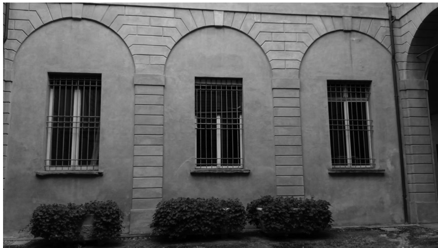
Foto 10 – Infissi delle aule verso la corte interna
