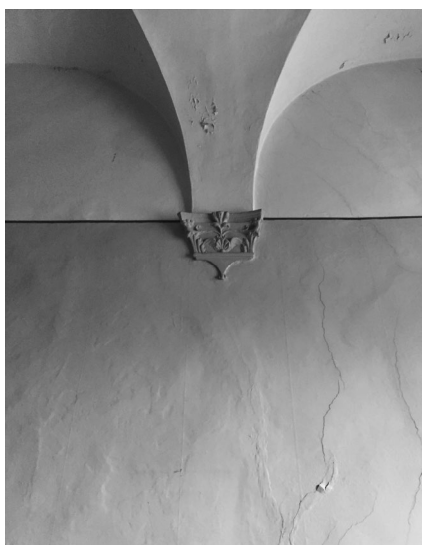
Foto 3-4 – Lesioni su cui intervenire tramite iniezioni di malte o resine..
