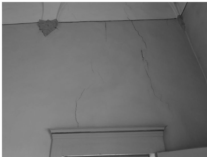
Foto 3-4 – Lesioni su cui intervenire tramite iniezioni di malte o resine..
