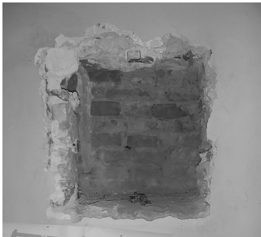
Foto 1-2 – Nicchie su muratura portante che verranno chiuse con tecnica cuciscuci.
